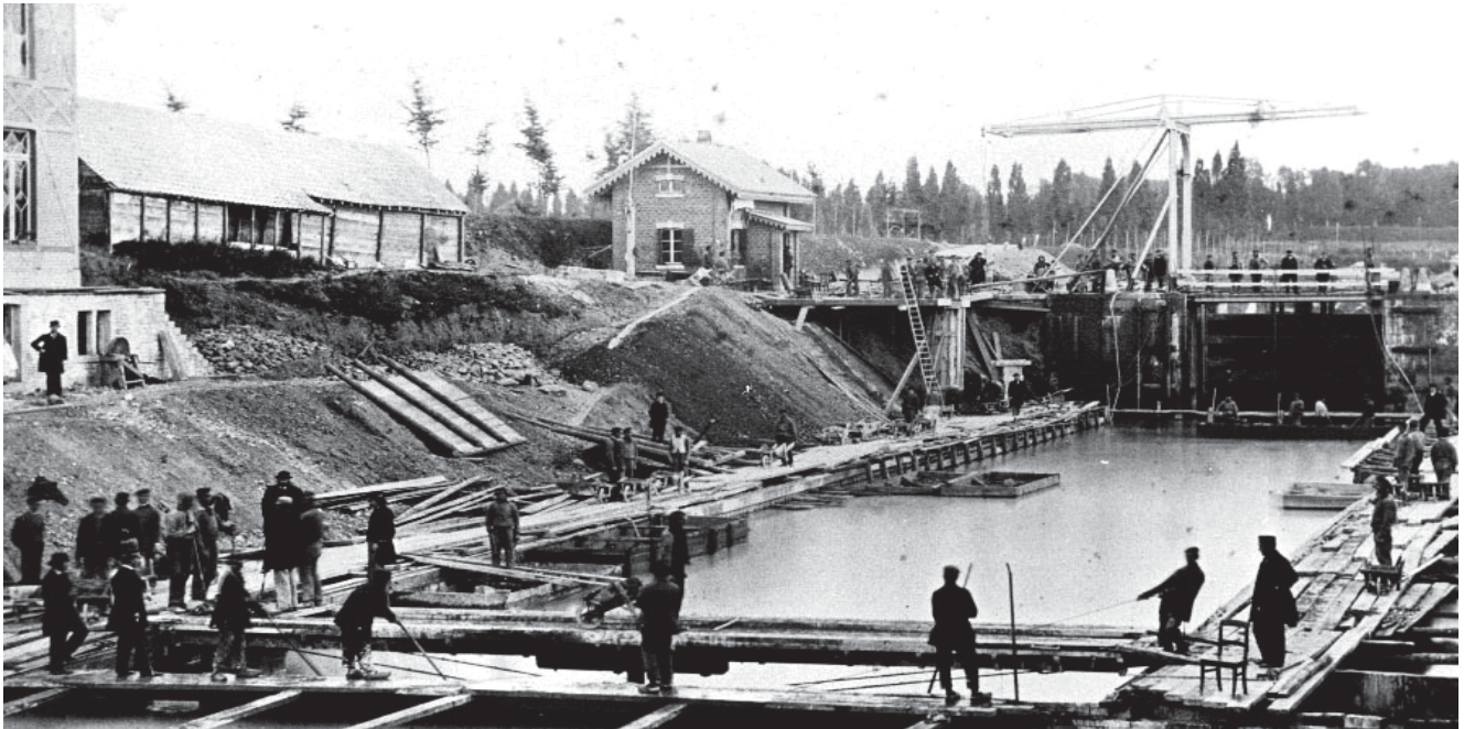
9 Aanleg van het Bassin te Maastricht (1824-1826)
